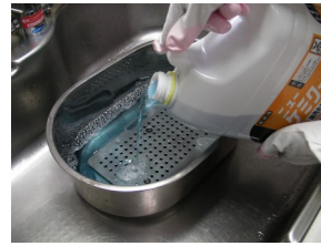
③60℃以上のお湯にアルカリ性洗剤を2~5倍程度に薄めます。(手袋着用)
